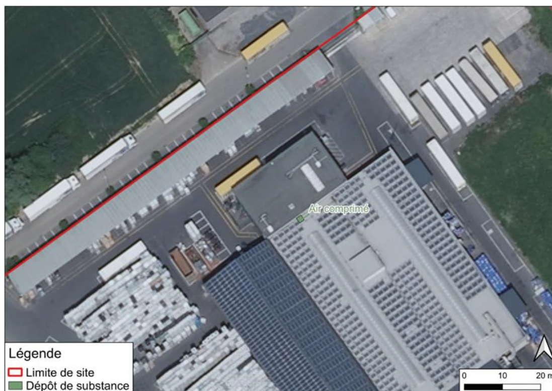
Figure 10 Localisation du dépôt d'air comprimé du site (fdp : WalOnMap)
